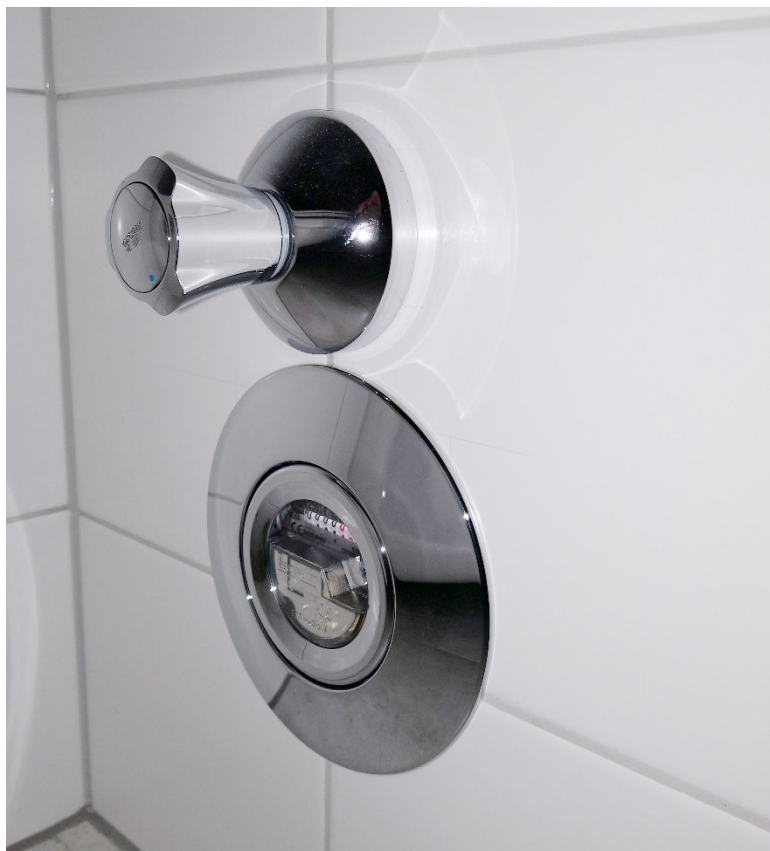
Abb. Funkzähler für Kaltwasser, Fa. Techem
